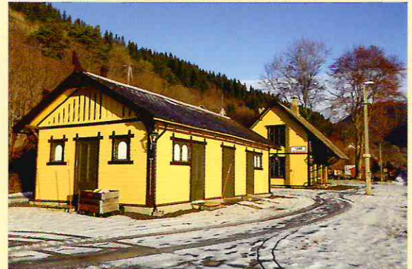
Ygre stasjon på bergensbanen restaurert tilbake til original stand i 2016. Linomal linoljemaling fra Møretyri AS. Hovedfarge NCS 2030-Y10R, dørene i Furugrønn og omramming NCS 8006-Y63R
